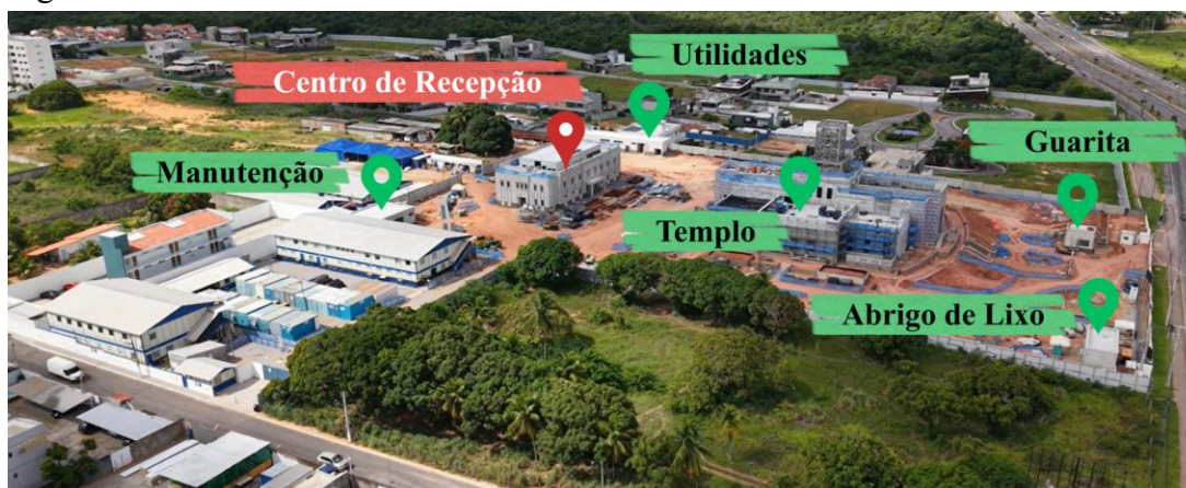
Figura 7 - Vista Aérea do Canteiro de Obras.
