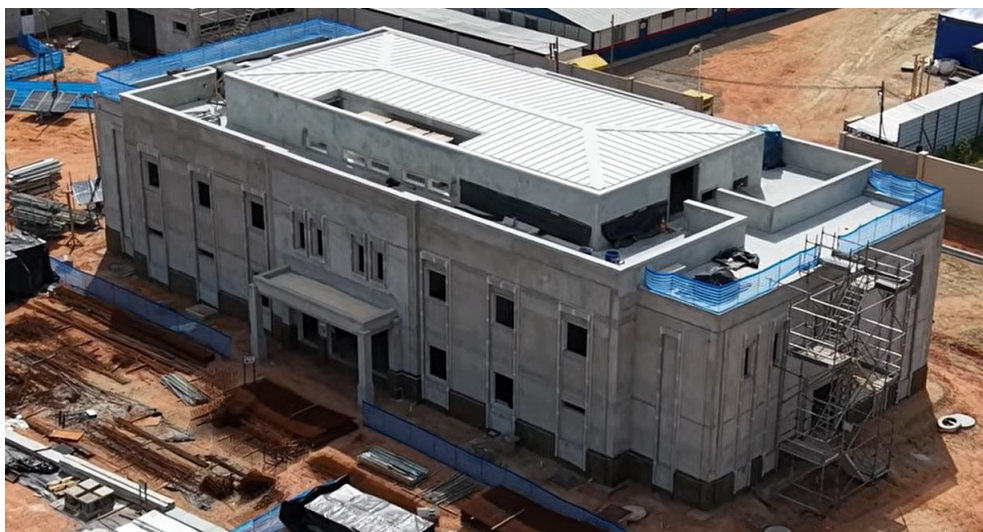
Figura 8 - Imagem Ampliada do Centro de Recepção em Andamento.
