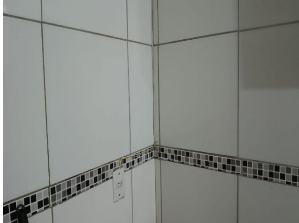
Figura 43 - Fiação exposta na cozinha.
