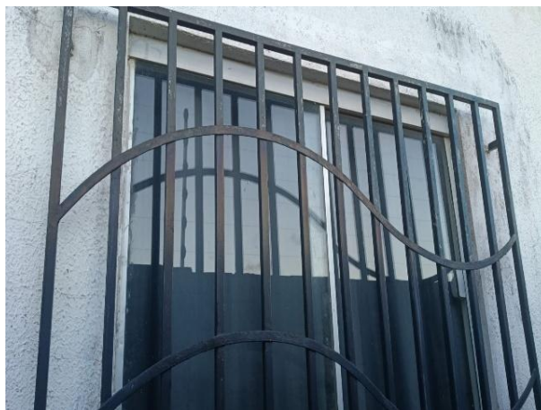
Figura 48 - Corrosão do gradil de proteção da janela do quarto.
