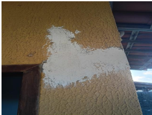
Figura 35 - Fissuras na porta da sala.
