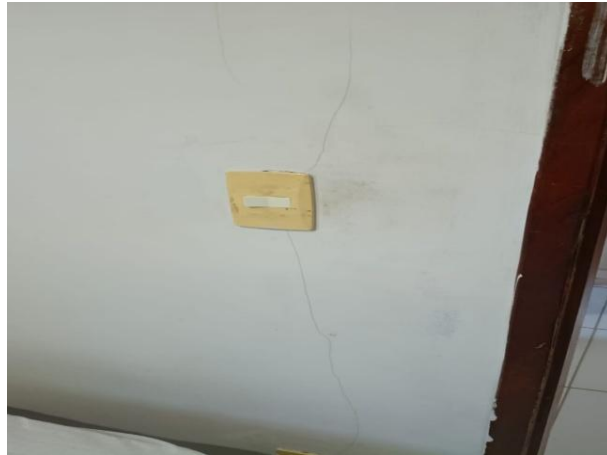
Figura 47 - Fissura na face externa da parede do quarto, próximo a janela.
