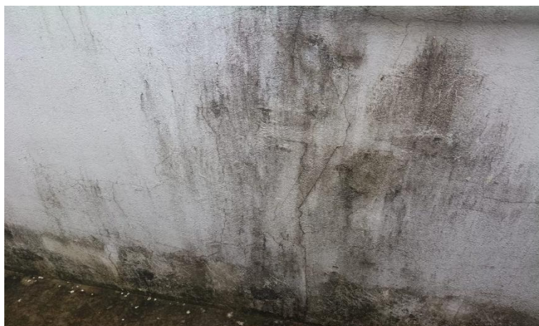
Figura 59 - Formação de lodo nas na face externa da parede de fundos.
