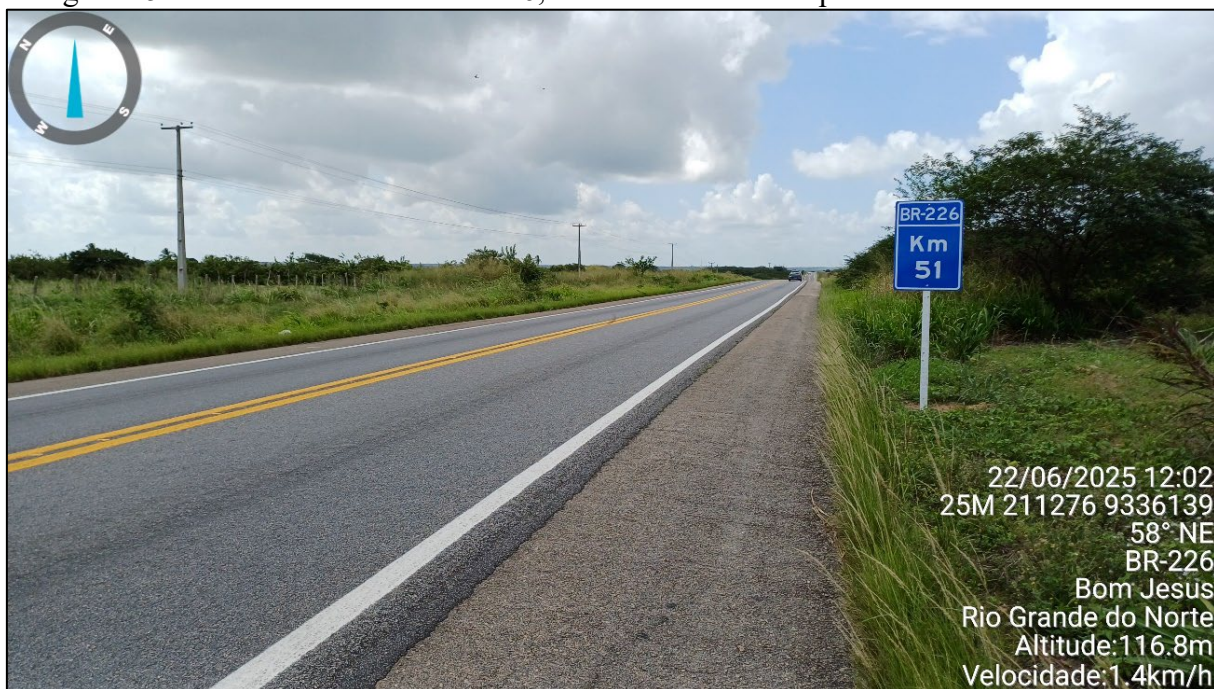
Fotografia 5 – Trecho da rodovia BR-226, zona rural do município de Bom Jesus-RN.
