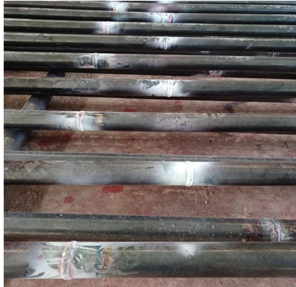
Figura 5 – Inspeção por líquido penetrante nas juntas soldadas
