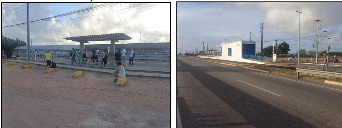
Figura 3 – Infraestrutura de mobilidade no entorno do Condomínio Mirantes da Lagoa: ponto de ônibus e estação ferroviária desativada
