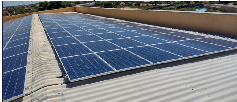
Figura 42 - Forma de instalação do sistema fotovoltaico campi de Lajes
