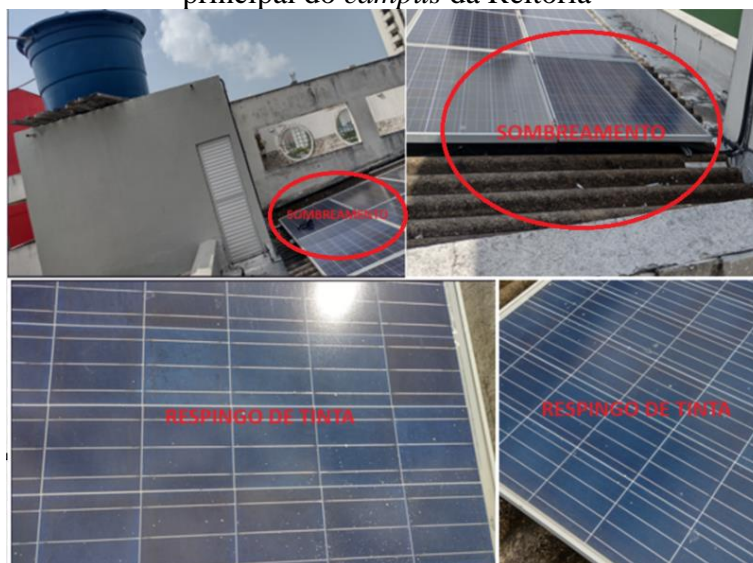
Figura 73 - Sombreamento e respingos de tinta sobre os módulos fotovoltaico do prédio principal do campus da Reitoria
