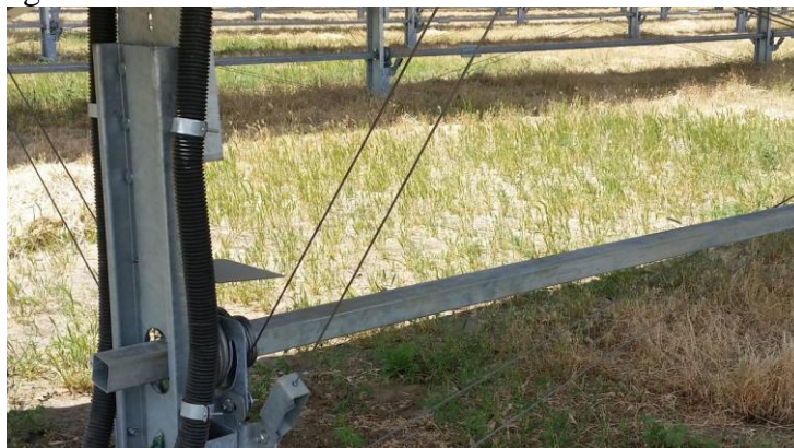
Figura 7 - Usina fotovoltaica da Tritec-Intervento no Chile
