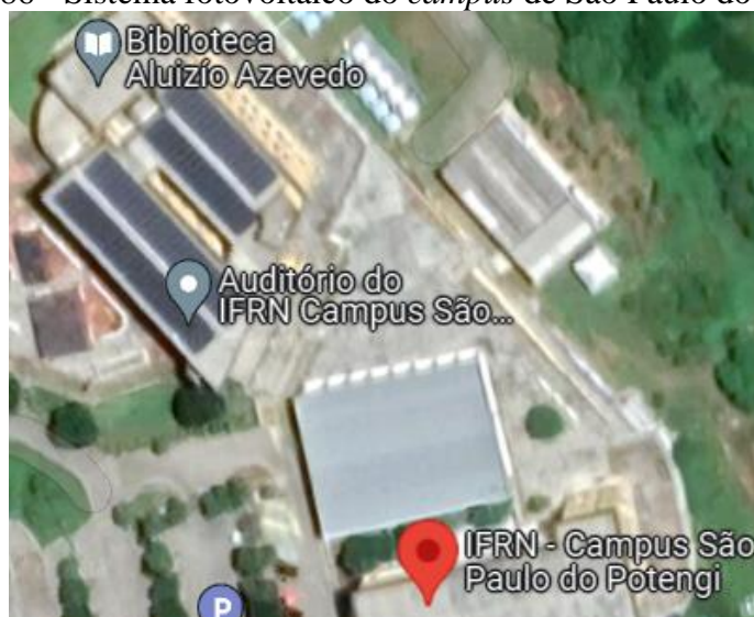
Figura 86 - Sistema fotovoltaico do campus de São Paulo do Potengi
