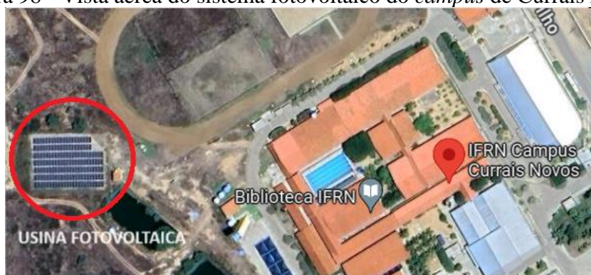
Figura 98 - Vista aérea do sistema fotovoltaico do campus de Currais Novos
