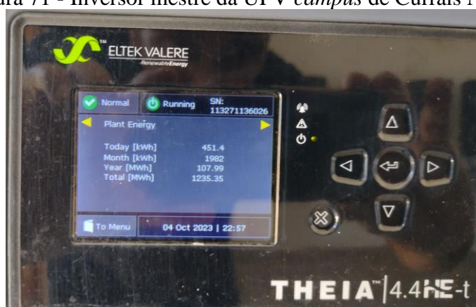
Figura 71 - Inversor mestre da UFV campus de Currais Novos
