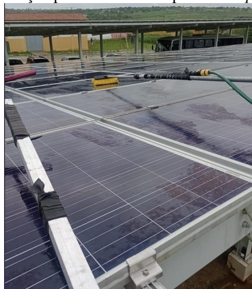
Figura 36 - Improvisação para realizar a limpeza – campus de João Câmara
