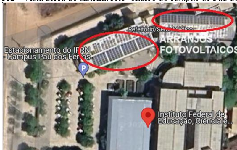
Figura 112 - Vista aérea do sistema fotovoltaico do campus de Pau dos Ferros
