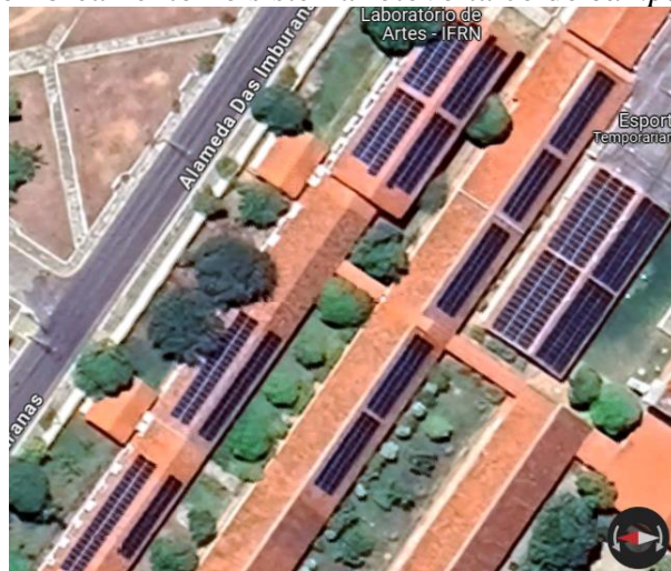
Figura 55 - Sombreamento no sistema fotovoltaico do campus de Mossoró
