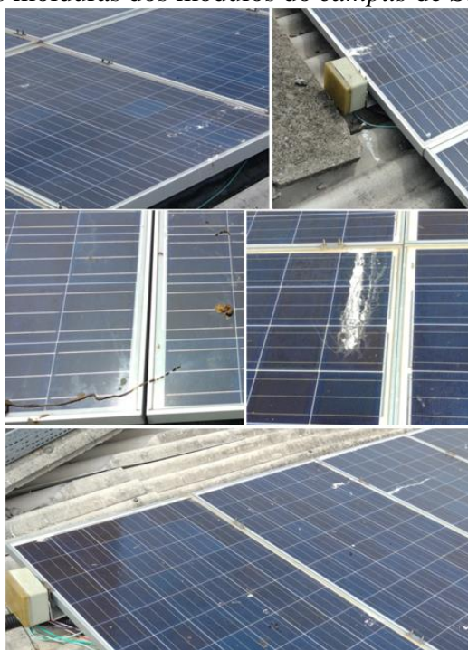
Figura 89 - Excrementos de aves depositadas sobre os arranjos fotovoltaicos e sujeira nas faces inferiores das molduras dos módulos do campus de São Paulo do Potengi
