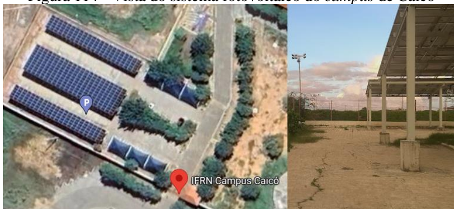
Figura 114 - Vista do sistema fotovoltaico do campus de Caicó
