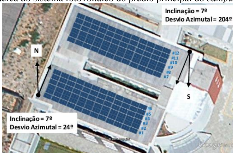
Figura 72 - Vista aérea do sistema fotovoltaico do prédio principal do campus da Reitoria
