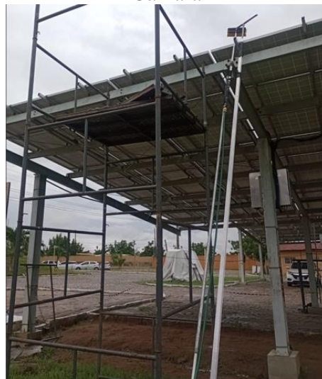
Figura 34 - Preparativos para realização da limpeza do sistema fotovoltaico – campus de João Câmara
