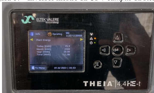
Figura 67 - Inversor mestre da UFV campus da Reitoria
