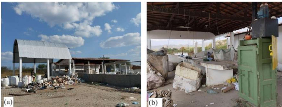
Figura 20: Infraestrutura em Acari: (a) galpão; (b) prensa enfardadeira.
