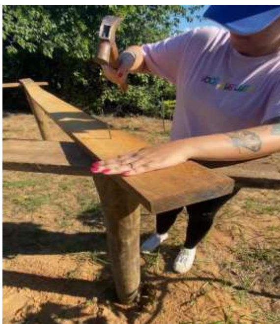
Figura 6: resto de madeiras de construção sendo reutilizadas
