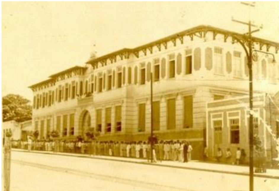
Figura 6 – Prédio da Avenida Rio Branco
