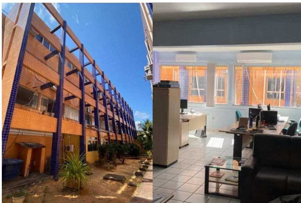
Figura 3 – Fachada lateral do prédio do NIT com incidência solar e efeito da incidência solar na ITNC (localizada no prédio)
