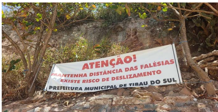
Figura 16 - Aviso da prefeitura de Tibau do Sul, RN sobre deslizamento de blocos na praia do Centro, Pipa/RN
