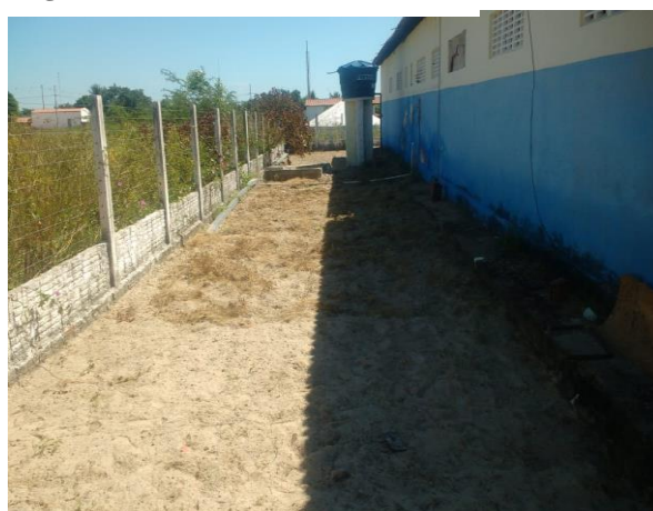
Figura 4 - Área interna da escola.
