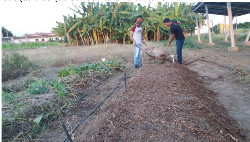
Figura 01: Construção e adição de cobertura no canteiro
