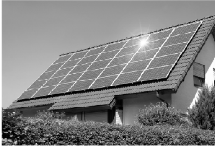
Figura 5 – Placas fotovoltaicas para a geração de eletricidade instaladas no telhado de uma residência.
