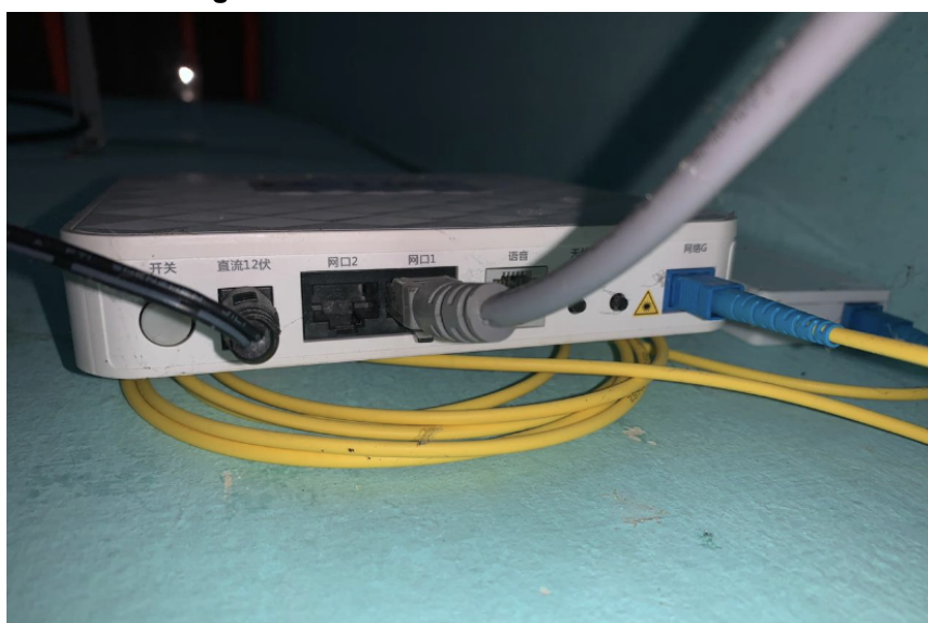
Figura 10- Conexão dos cabos no modem
