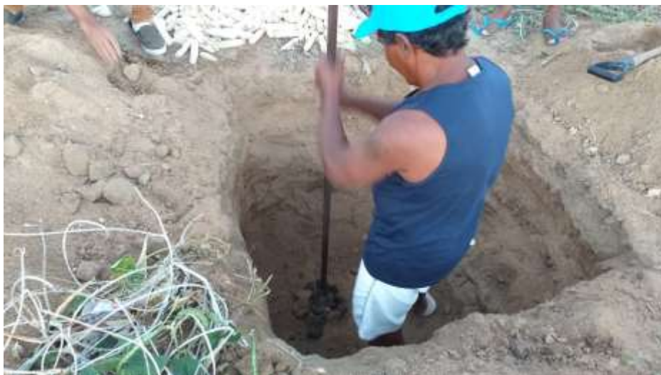
Figura 5 – Abertura da trincheira
