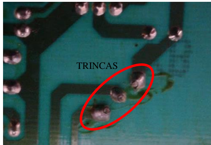
Figura 07- Placa apresentou mau contato por trinca em solda
