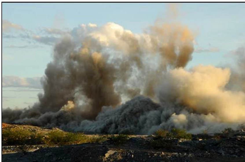
Figura 13 – Geração de poeiras e gases após detonação
