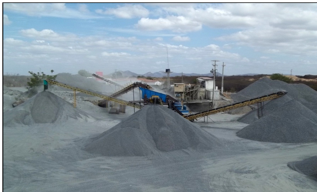
Figura 6 – Planta de britagem
