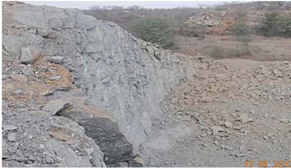
Figura 2 – Talude remanescente da Mineração Dantas Gurgel & Cia Ltda desmontado com uso de espoleta eletrônica
