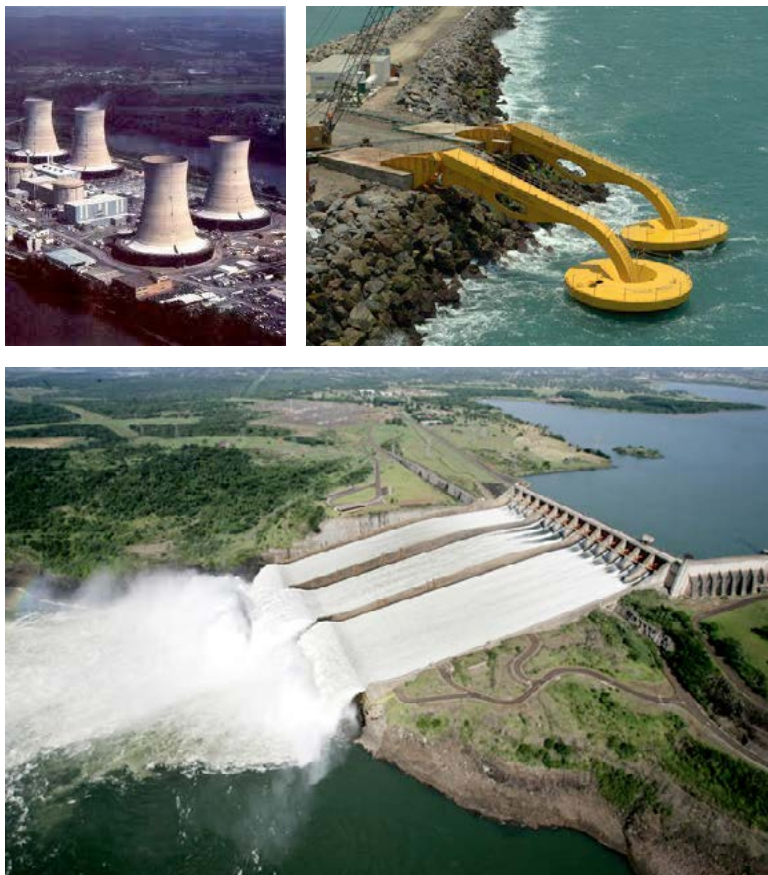
Figura 51: Exemplo de fontes geradoras de eletricidade
