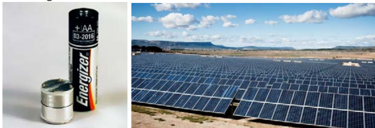
Figura 52: Exemplo de geradores de eletricidade que não utilizam turbinas geradoras
