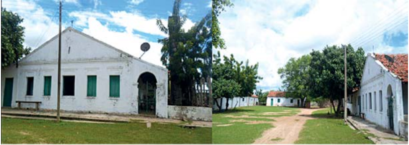
Figura 6- Aspecto do antigo engenho Pitombeira de Taipu
