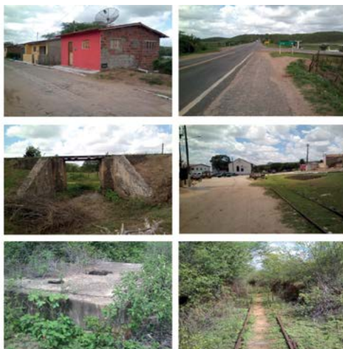
Figura 46- Situação atual da ferrovia II
