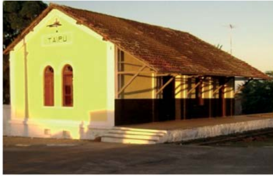
Figura 33- estação ferroviária de Taipu em 2012.
