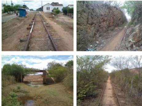
Figura 45-Situação atual da ferrovia em Taipu I.
