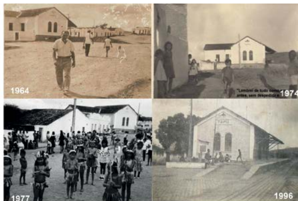
Figura 38 - Largo da estação ferroviária em diversas épocas.
