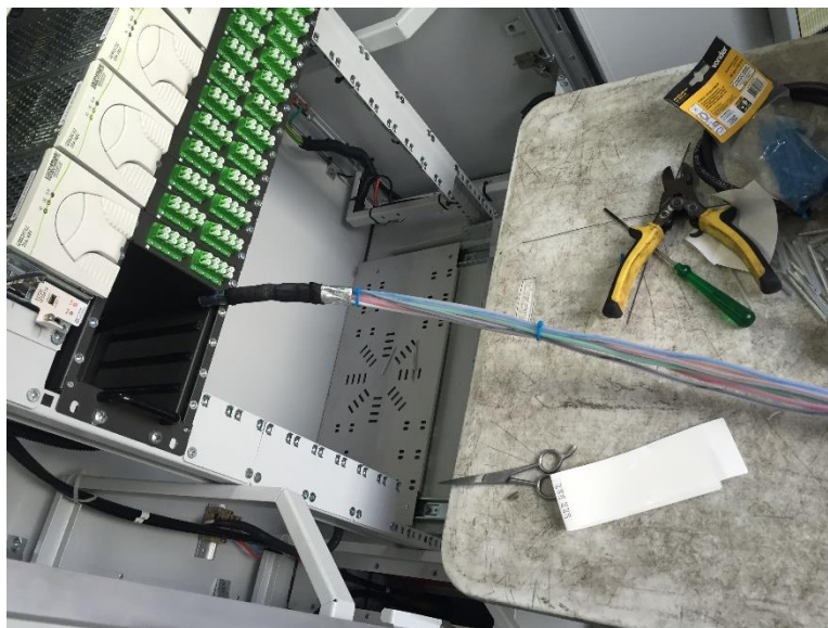
Figura 21 – Cabo óptico 64FO pronto para ser acomodado nos slots DIO
