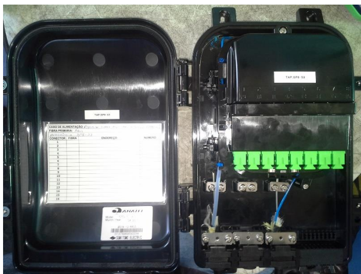
Figura 30 – Interior do TAP óptico com identificação de sequência de acordo com projeto óptico (item 4.2)
