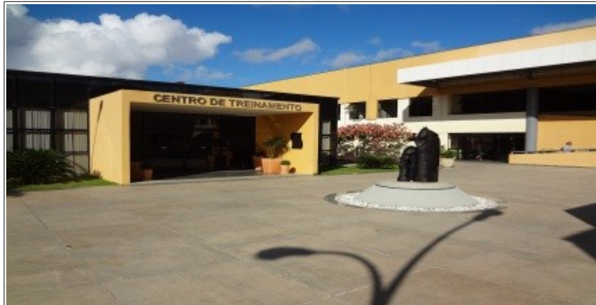
Figura 2 - Fachada do COJE do TRE-RN
