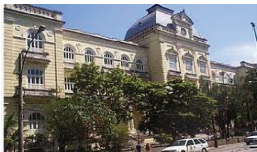
Fig. 06 Prédio do INES
