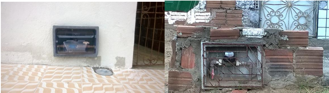
Figura 3: hidrômetros e situação regular com a devida proteção.
