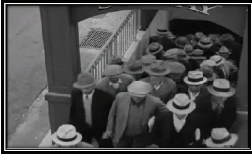
Imagem 2: Operários entrando na fábrica.
