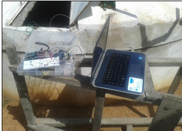
Figura 5 – Testes em cisterna de 16 mil litros.
