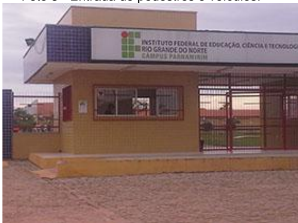
Foto 3 - Entrada de pedestres e veículos.
