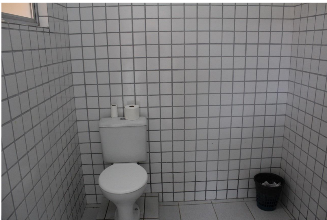
FIGURA 28 - Sanitário do banheiro acessível
