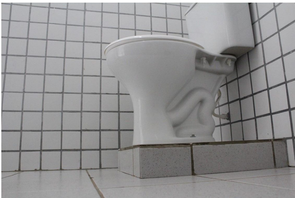
FIGURA 29 - Sanitário, visualização da plataforma
