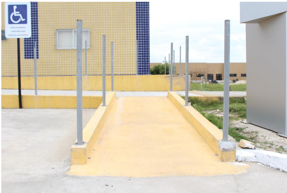
Figura 8 - Rampa de acesso
