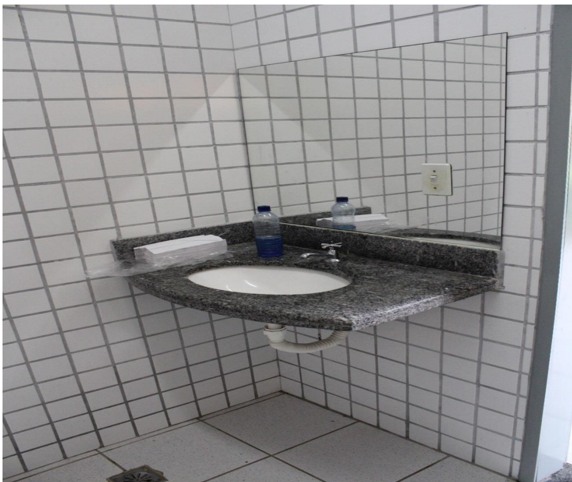
FIGURA 31 - Lavatório do banheiro acessível
