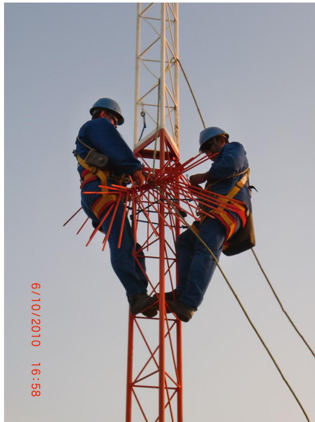
Figura 22 - Montagem da torre de medição. Fonte: Gerente Executivo dos Parques Eólicos de Alegria I e II.
