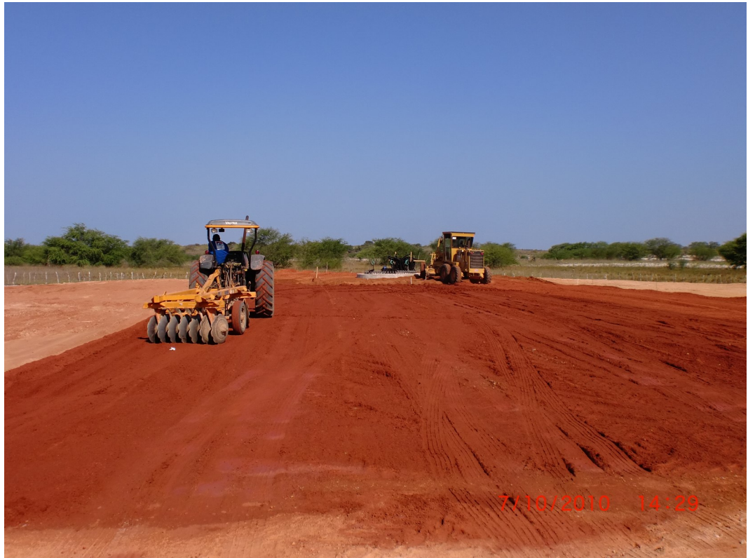
Figura 35– Terraplanagem durante fase de construção. Fonte: Gerente Executivo dos Parques Eólicos de Alegria I e II.
