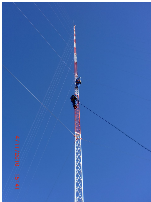
Figura 23 - Montagem da torre de medição. Fonte: Gerente Executivo dos Parques Eólicos de Alegria I e II.
