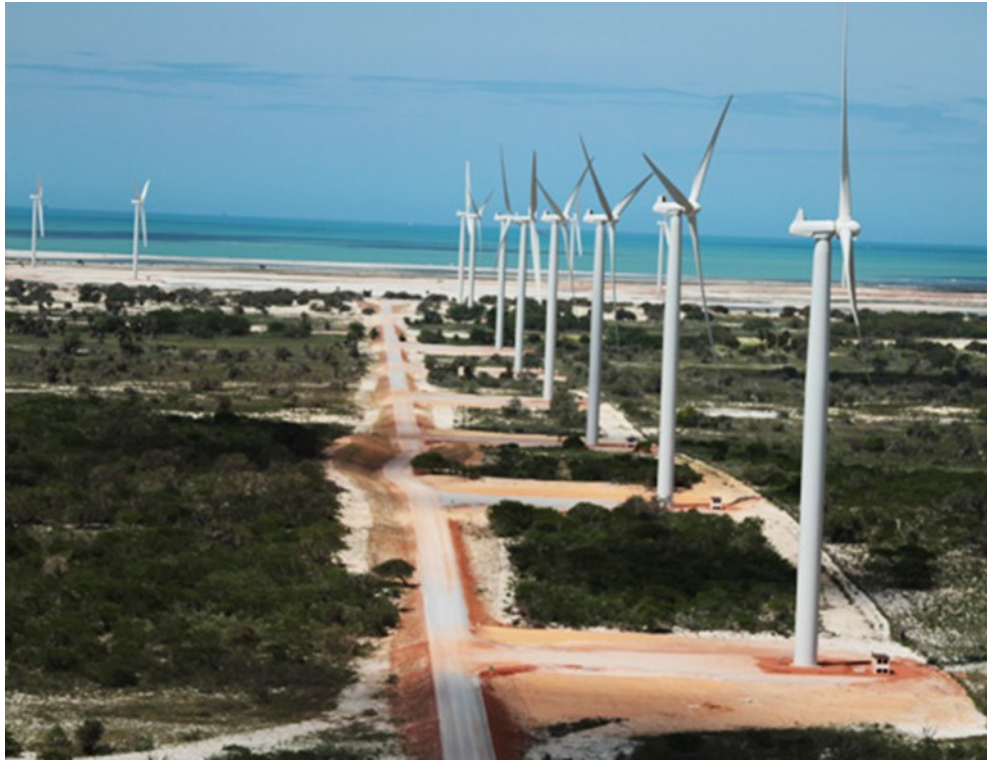
Figura 31-Via de Acesso para o Parque Eólico. Fonte: Parque Eólico Alegria.
