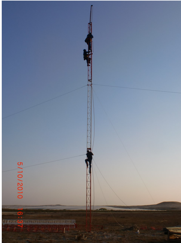
Figura 24 - Montagem da torre de medição. Fonte: Gerente Executivo dos Parques Eólicos de Alegria I e II.
