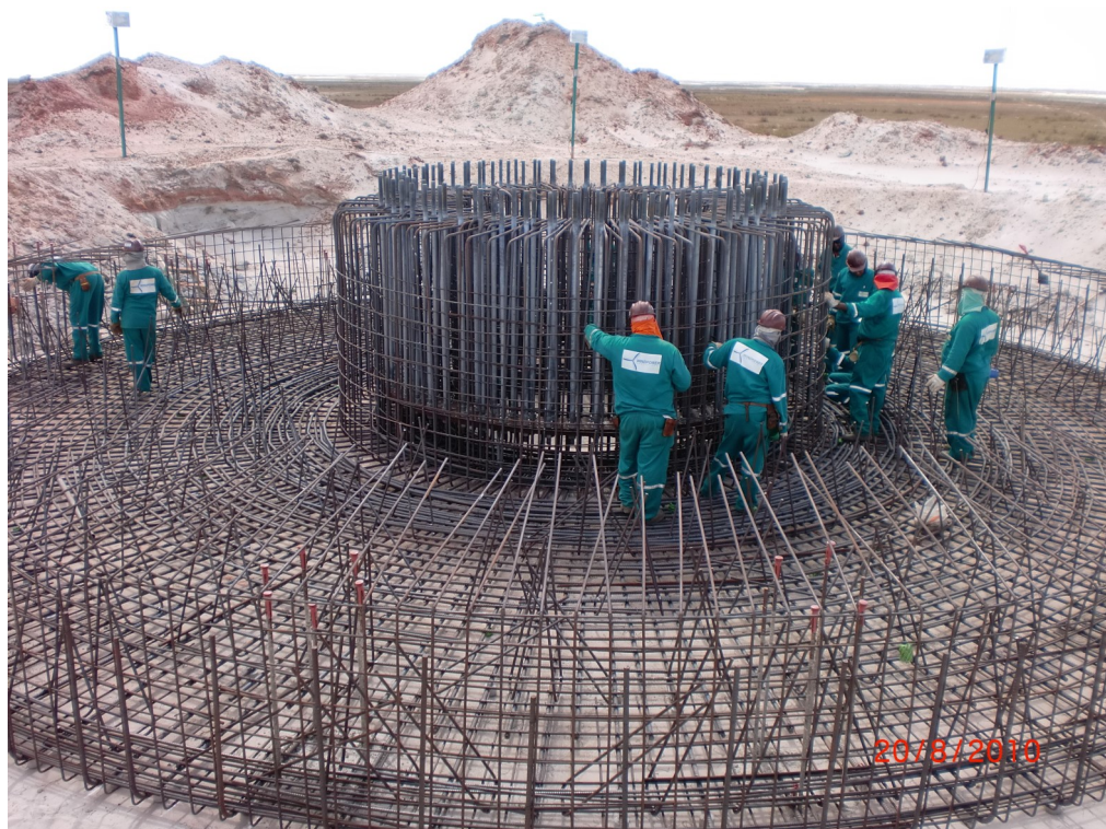
Figura 39– Armação da base da fundação. Fonte: Gerente Executivo dos Parques Eólicos de Alegria I e II.
