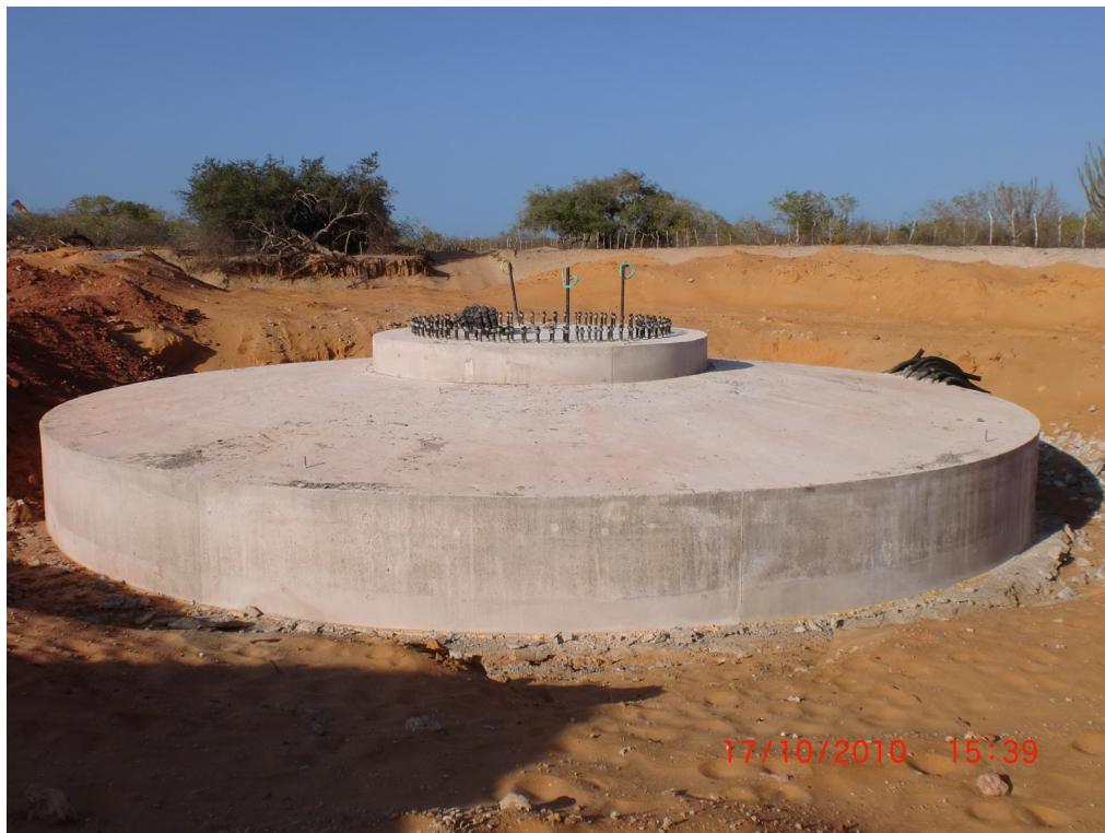
Figura 43– Base da fundação concluída. Fonte: Gerente Executivo dos Parques Eólicos de Alegria I e II.
