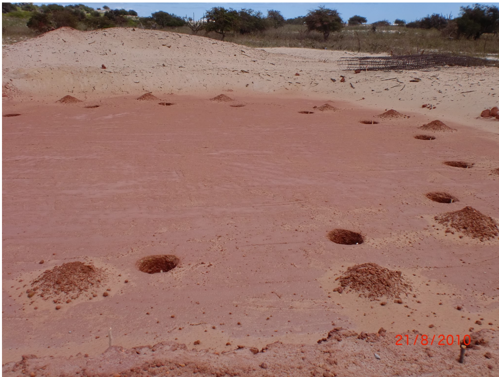
Figura 36– Marcação do posicionamento das estacas da fundação. Fonte: Gerente Executivo dos Parques Eólicos de Alegria I e II.
