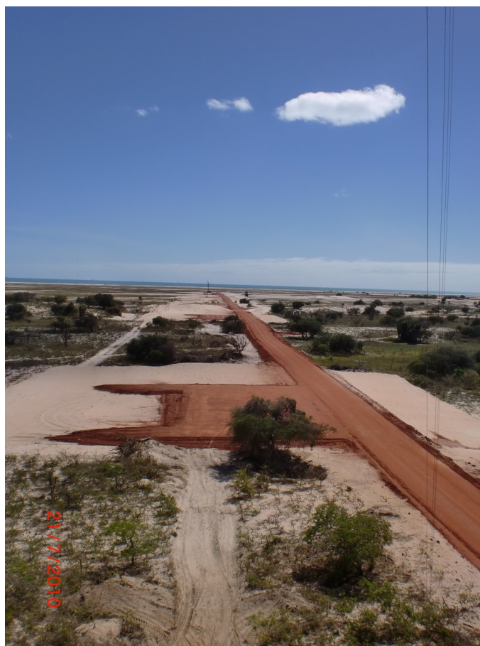
Figura 30– Construção de vias de acesso e de área onde se localiza a turbina eólica e a subestação dedicada. Fonte: Gerente Executivo dos Parques Eólicos de Alegria I e II.
