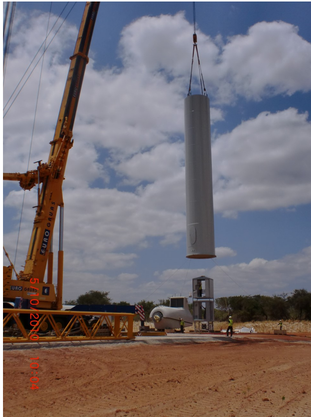
Figura 46– Montagem do primeiro estágio da torre. Fonte: Gerente Executivo dos Parques Eólicos de Alegria I e II.
