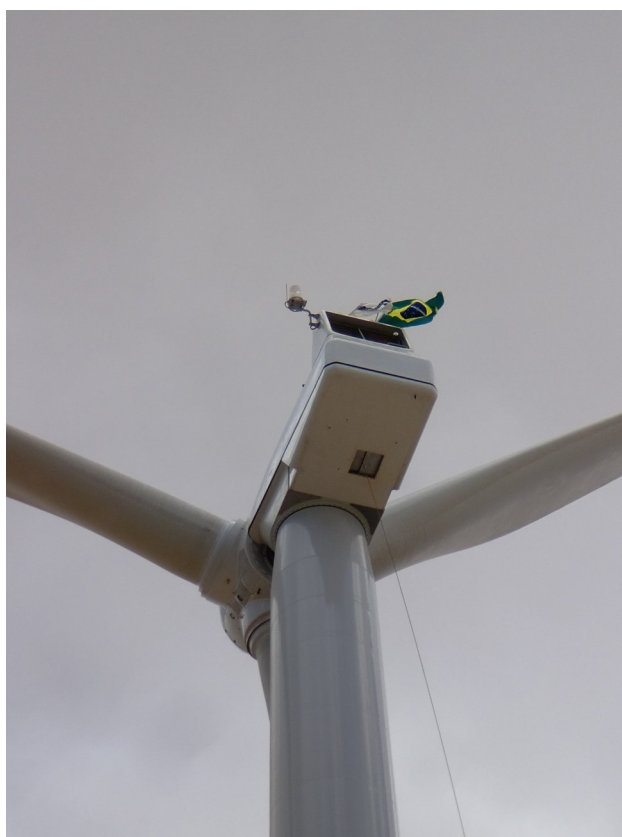
Figura 50– Montagem da nacele na torre. Fonte: Gerente Executivo dos Parques Eólicos de Alegria I e II.
