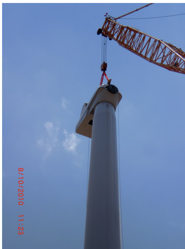
Figura 51– Montagem do cubo na nacele. Fonte: Gerente Executivo dos Parques Eólicos de Alegria I e II.
