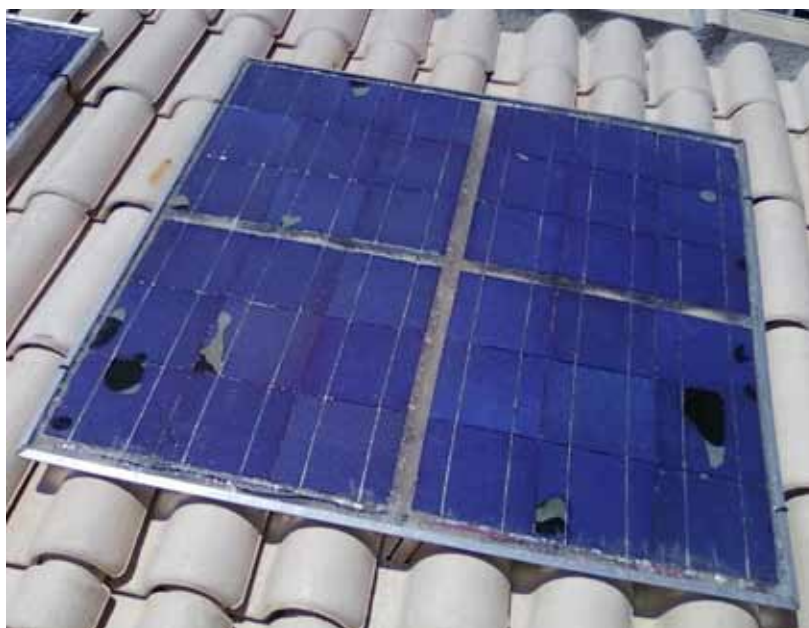
Figura 6 – Painel solar construído.
