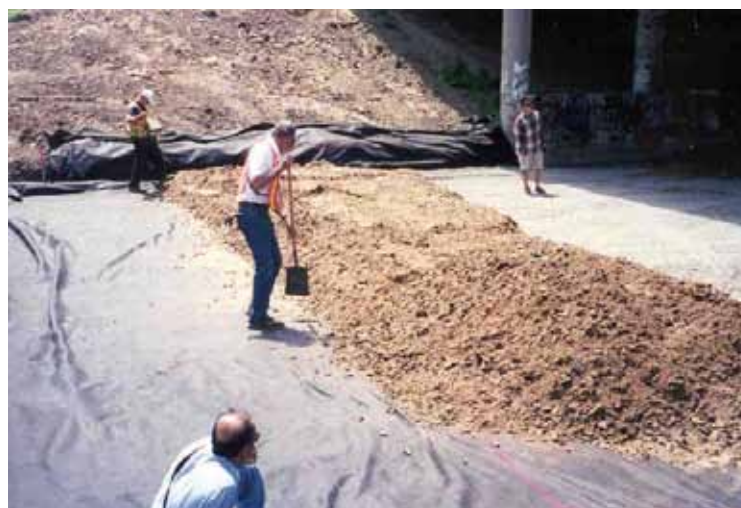
Figura 2 – Colocação da mistura pneu-areia (YOON et. al., 2005)
