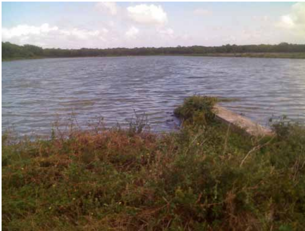
Figura 04-Aspecto da topografia plana onde está localizada a lagoa de captação.
