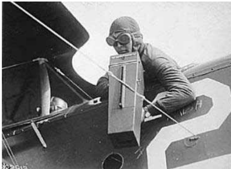
Figura 1 – Câmera fotográfica usada durante a I Guerra Mundial, bastante rústica e especialmente desenvolvida para uso em aviões. Fonte: Campbell, 2007.
