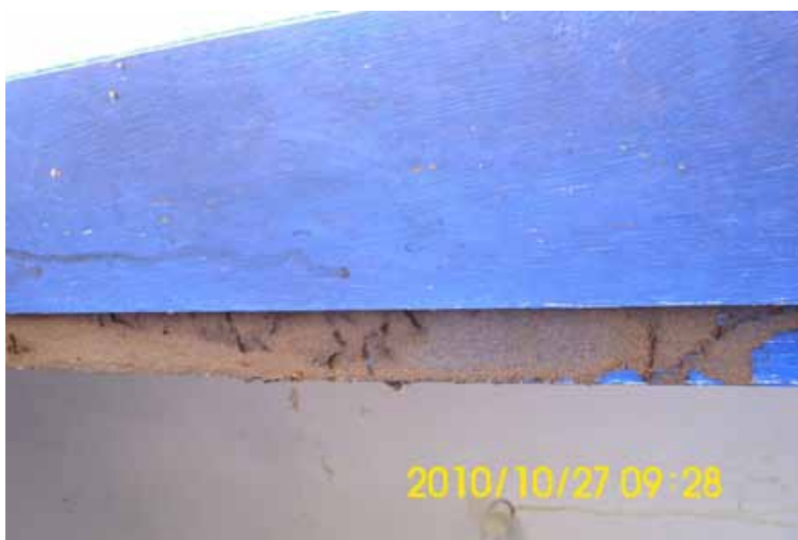
Figura 6 – Proliferação de cupins nas janelas
