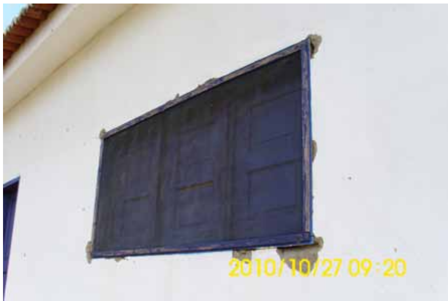
Figura 5 – Janela de madeira telada
