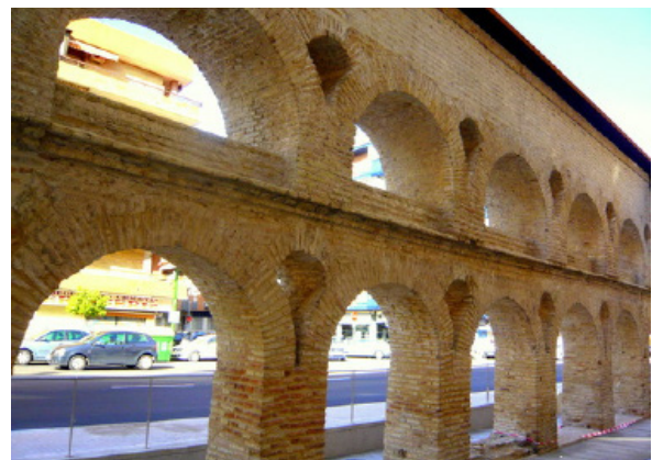
Fig. 06 - Caños de Carmona. Sevilla.
