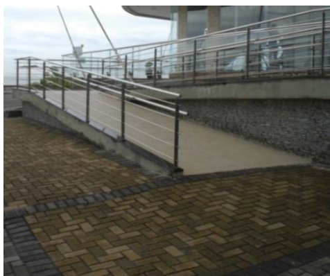
Figura 2 - Rampa de acesso na esquina da Fachada Norte com a Leste.
