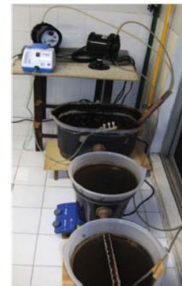
Figura 2b – Sistema em operação tratando esgoto doméstico.
