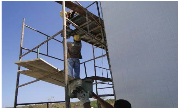
Figura 1: Execução de revestimento cerâmico
