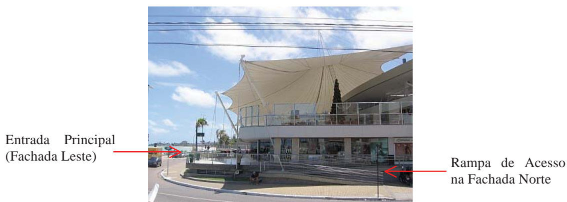
Figura 4: Rampa de acesso na esquina da Fachada Norte com a Fachada Leste.
