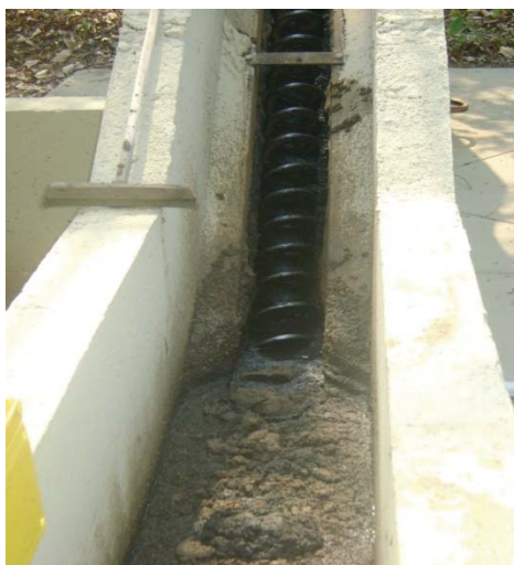
Figura 06- Desarenador, ETE Pernada, Paraíso do Tocantins-TO.
