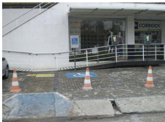
Figura 3: Rampa de acesso na entrada Oeste com vagas na frente da rampa.
