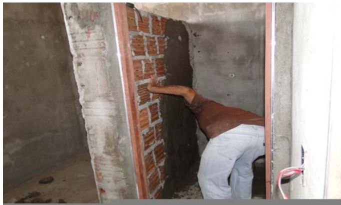
Figura 2: Execução de reboco em massa única
