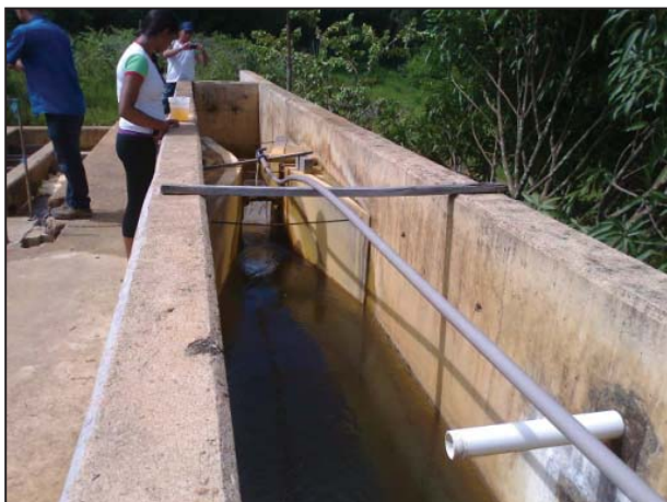
Figura 2 – Pontos de coleta das amostras. Calha Parshal - medição da vazão.
