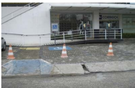
Figura 12: Sinalização horizontal e vertical.
