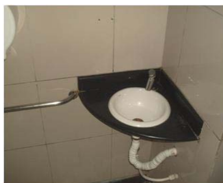
Figura 11: Lavatórios dos banheiros.
