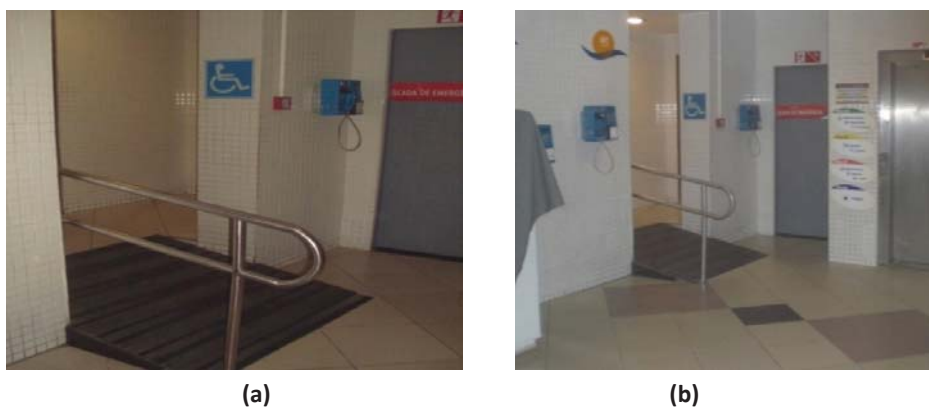
Figura 8: Acesso aos sanitários do primeiro pavimento.
