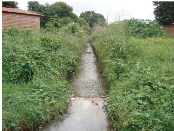
Figura 4- Galeria de águas pluviais do bairro São Francisco.
