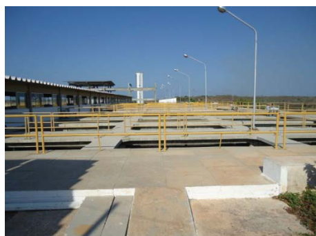
Figura 1: Filtros da ETA-Gavião (setembro/2010 - autor).
