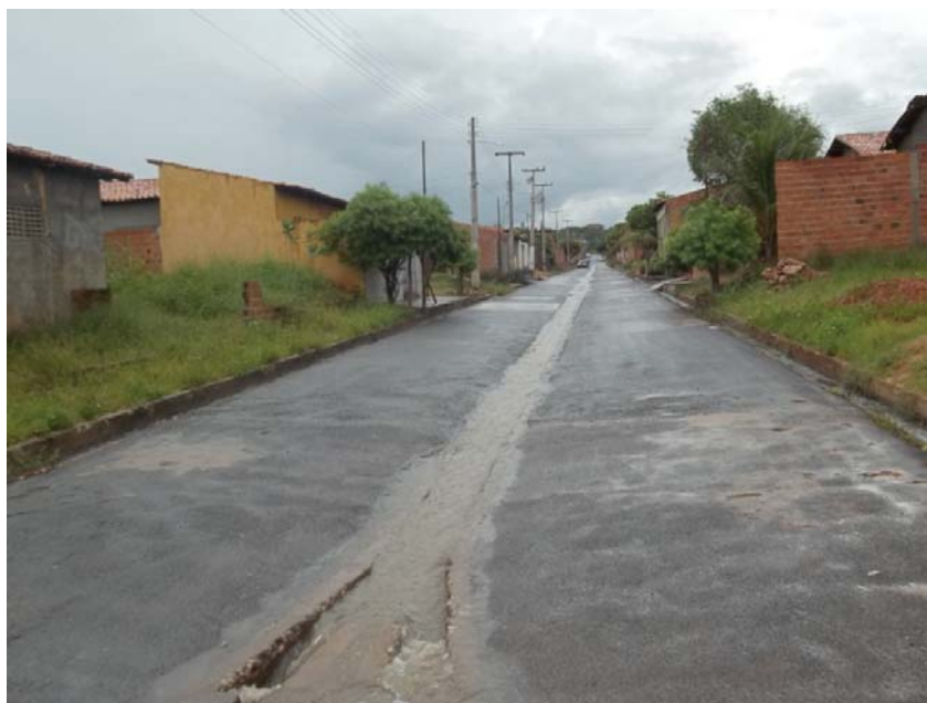
Figura 1: água escoando pelo sarjetão após precipitação.
