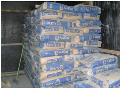
Figura 01- Armazenamento do cimento – Obra B Fonte: equipe de pesquisa.
