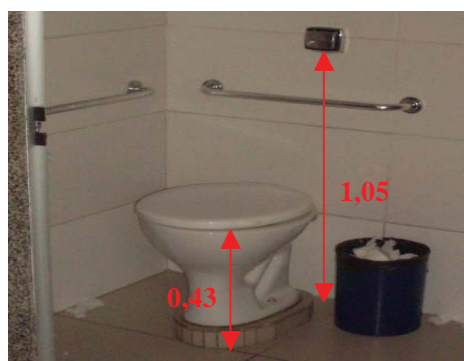
Figura 10: Bacia sanitária adaptada a PNE.
