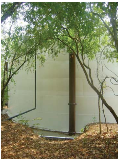
Figura 08- Reator UASB da ETE Pernada, de Paraíso do Tocantins-TO.
