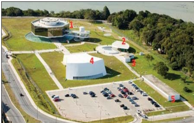
Figura 2- Edifícios componentes da Estação Ciência Cabo Branco
