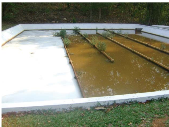
Figura 09- Tanque de Desinfecção, ETE Pernada, Paraíso do Tocantins-TO.
