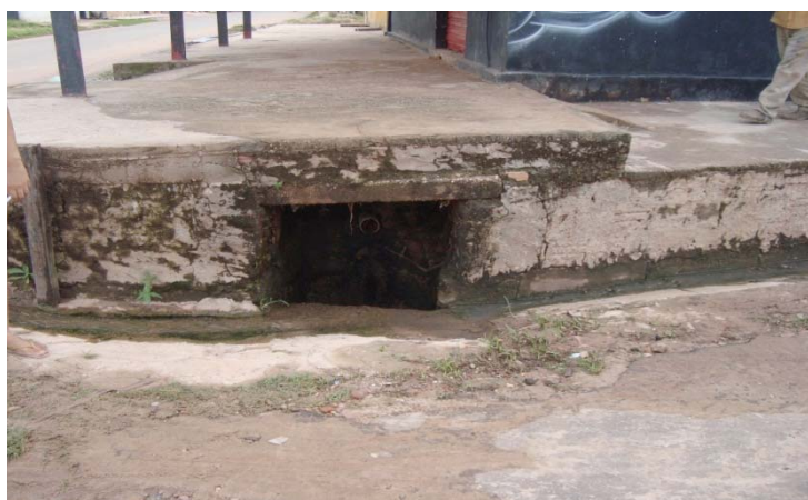
Figura 2- Boca de lobo sem grade.
