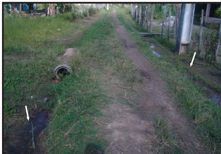
Figura 2 – Vala negra formada por lançamento de esgotos.
