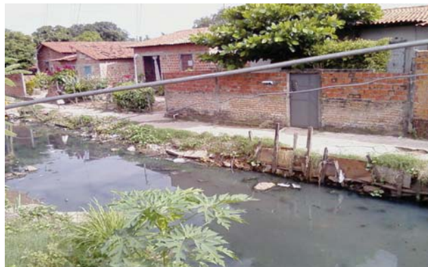
Figura 3: Esgotos a céu aberto e lixo doméstico exposto no bairro Nova Brasília
