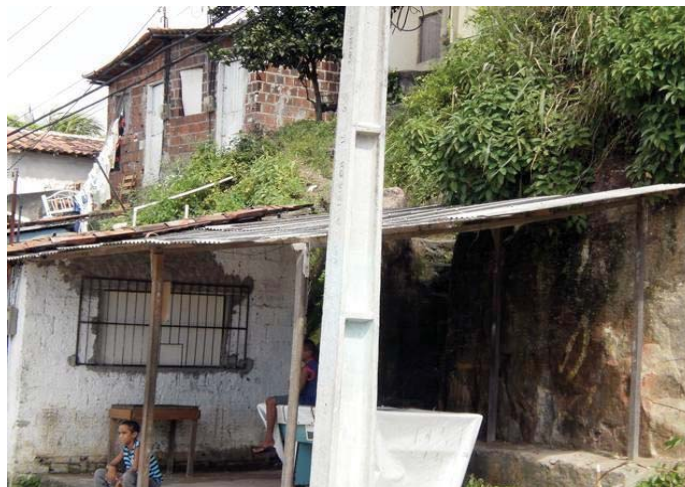
Foto 3 - Presença de construções irregulares na base e no topo da encosta
