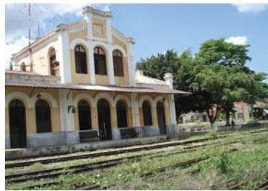
Figura 2 - Prédio da Estação Ferroviária de Baturité – 2008.
