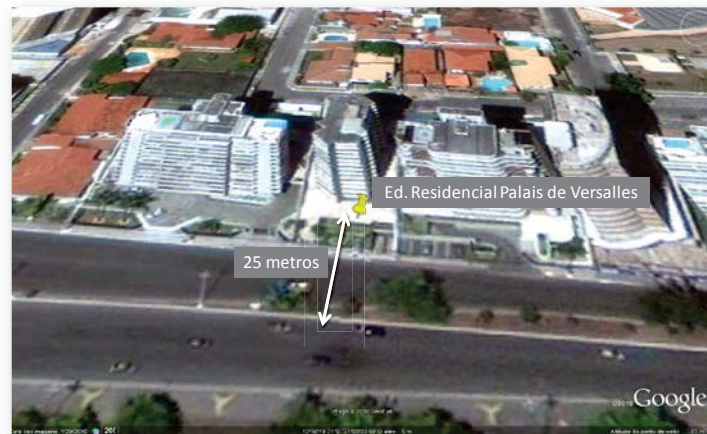
Figura 2 - Edifício residencial Palais de Versailles. (Fonte: Google Earth)
