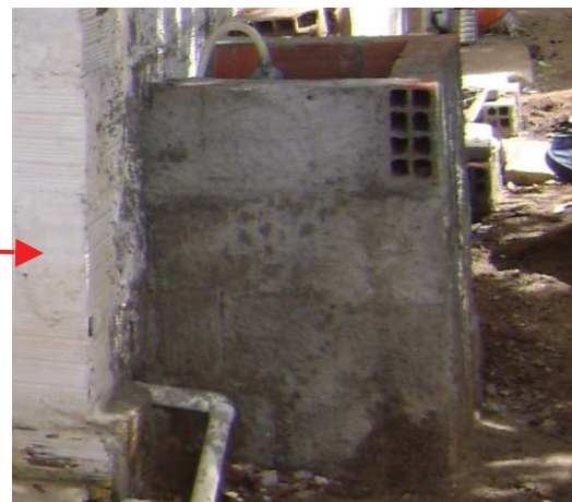
Figura 15b-detalle da instalação do botijão
