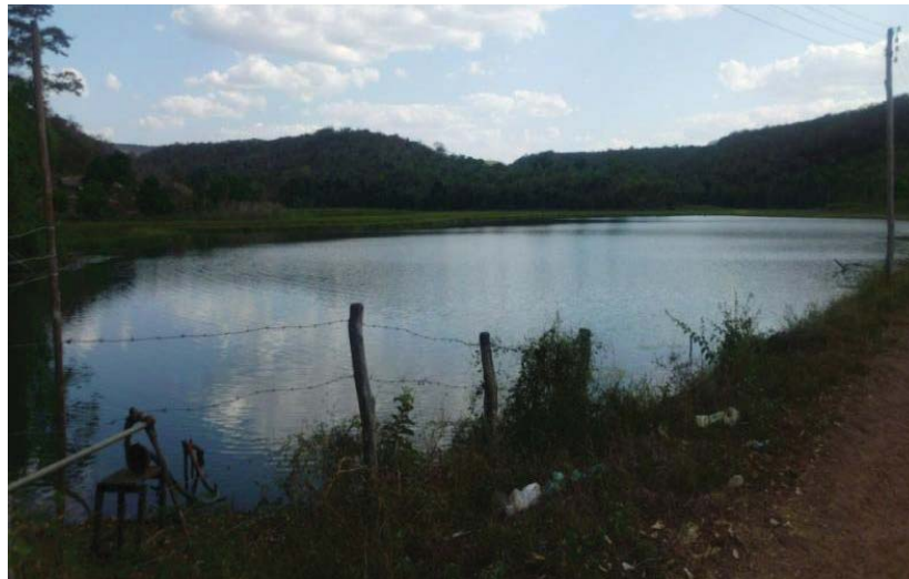
Figura 3: Barragem de Miguel Leão-PI.
