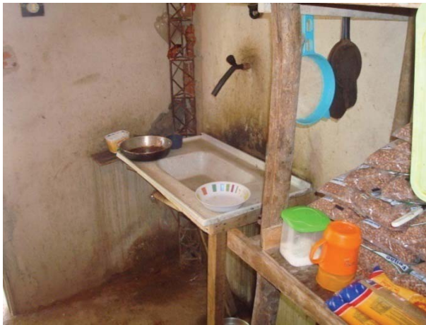
Figura 13 – instalação da pia na cozinha.
