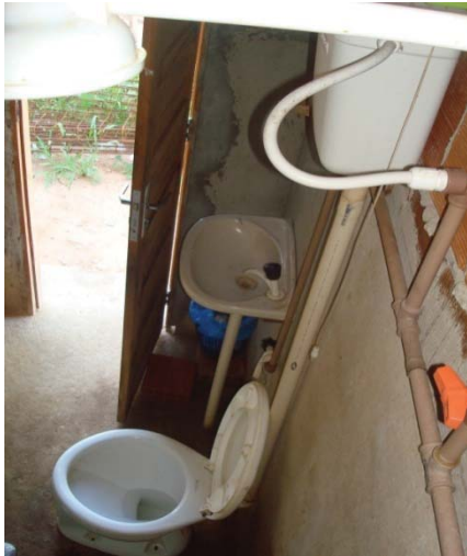
Figura 3 – Vaso sanitário com acento e caixa de descarga, lavatório e cesto para papel usado
