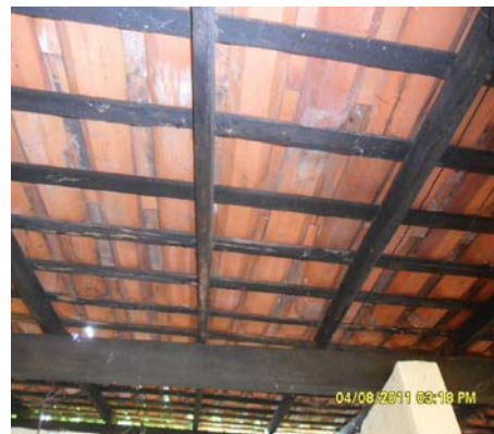
Figura 7: Teto de difícil higienização.
