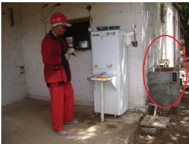
Figura 15a-local de instalação do botijão de GLP
