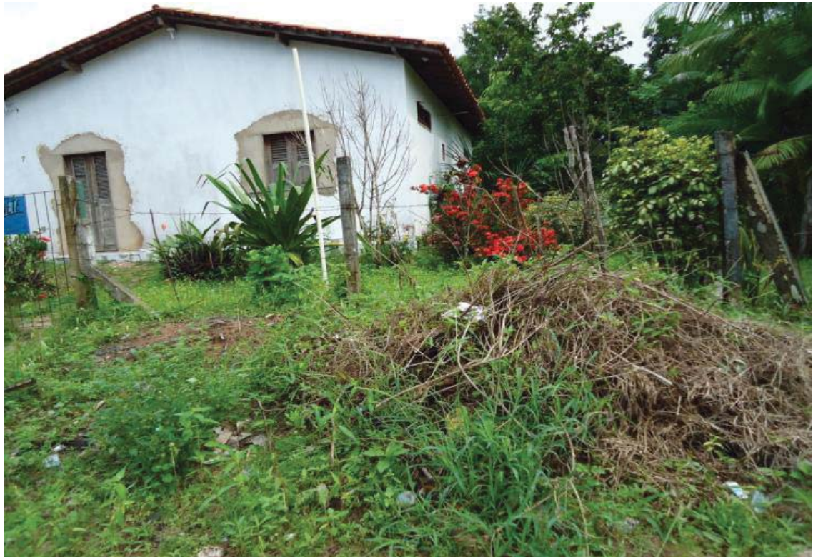
Figura 6- Entulhos próximos as casas
