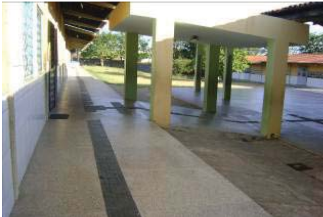
Figura 2 – Rampa e piso tátil no interior da escola
