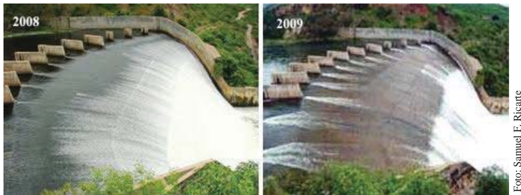
Figura 4 - Sangria do reservatório nos anos de 2008 e 2009.
