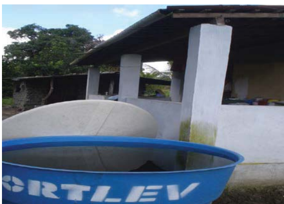
Figura 7. Caixa de água localizada na parcela 72, do Assentamento Serra Grande.
