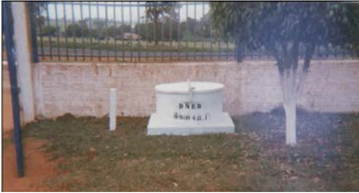
Figura 05- Abrigo de equipamento para contagem de tráfego utilizado no PNCT (DNIT, 2006).
