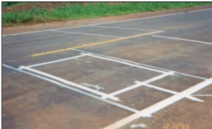
Figura 06- Sensor para contagem de tráfego utilizado no PNCT (DNIT, 2006).
