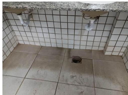
Figura 25 (b) – Caixa sifonada sem grelha
