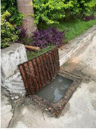
Fig.30 a) Caixa de esgoto obstruída com tampa irregular
