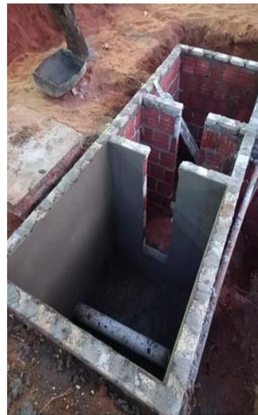
Figura 09 – b) Execução da caixa do medidor de vazão      Figura 09 – c) Execução da caixa do medidor de vazão
