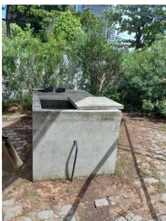
Figura 02.a – Caixa do medidor de vazão
