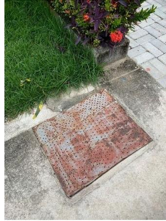
Fig.30 b) Caixa de esgoto com tampa irregular
