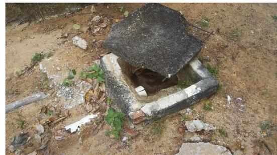
Fig. 29 b) – Caixa de inspeção com extravasor
