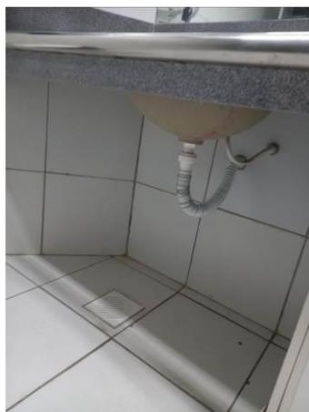
Figura 23 (a) – Fecho hídrico conforme norma
