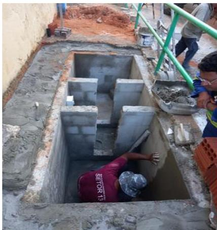
Figura 08 (b) – Execução da caixa do medidor de vazão
