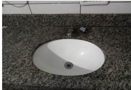
Figura 16 (b): Lavatório com torneira danificada
