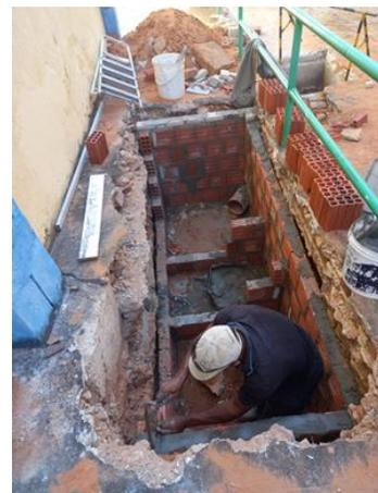
Figura 08 (c) - Execução da caixa do medidor de vazão
