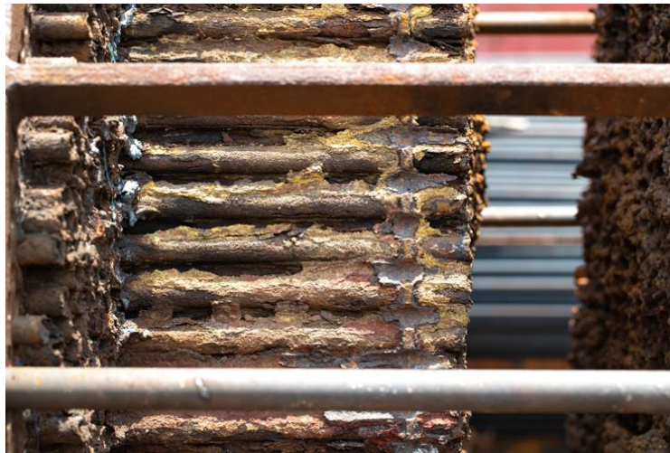
Figura 13: Formação de Fouling [2]
