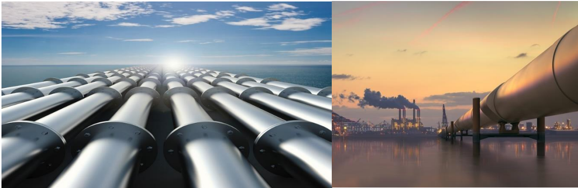
Figuras 8 e 9: Oleodutos e Gasodutos.
