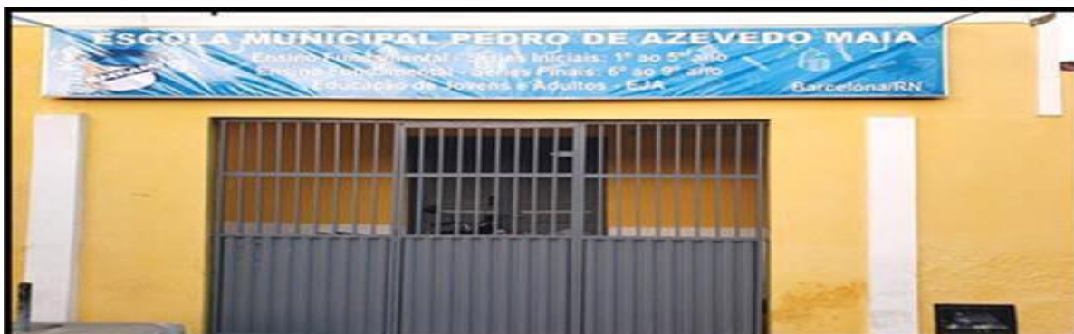
Figura 2: Fachada da Escola Municipal Pedro de Azevedo Maia – 2017.
