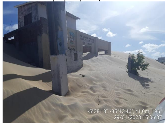
Figura 19 – Construção de imóvel em área de duna móvel. Fonte: Autoria própria (2023).
