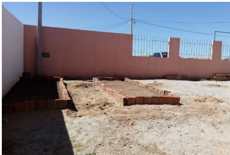
Figura 11 – Estruturação dos canteiros.
