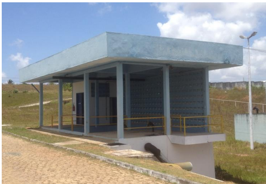
Figura 17 - Estação elevatória de resíduos gerados.
