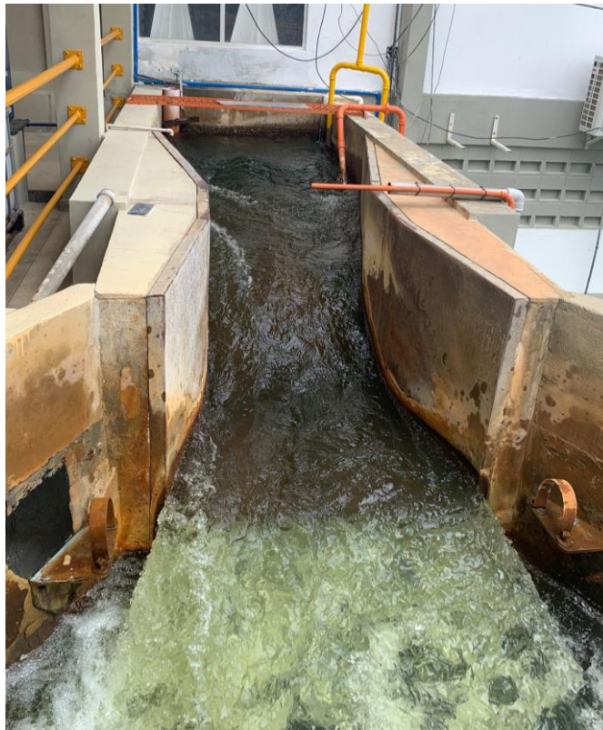
Figura 09 - Processo de “mistura rápida” na Calha Parshall .
