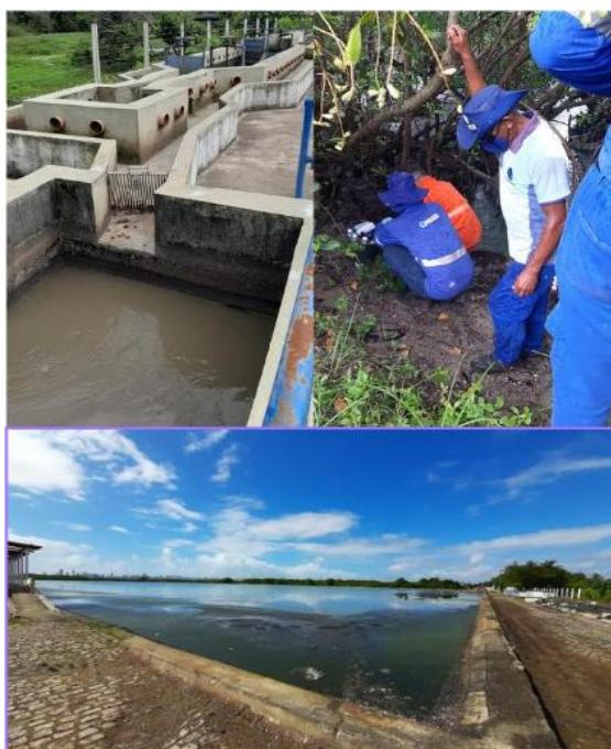
Figura 32: Estação de Tratamento de Esgoto do Beira Rio.
