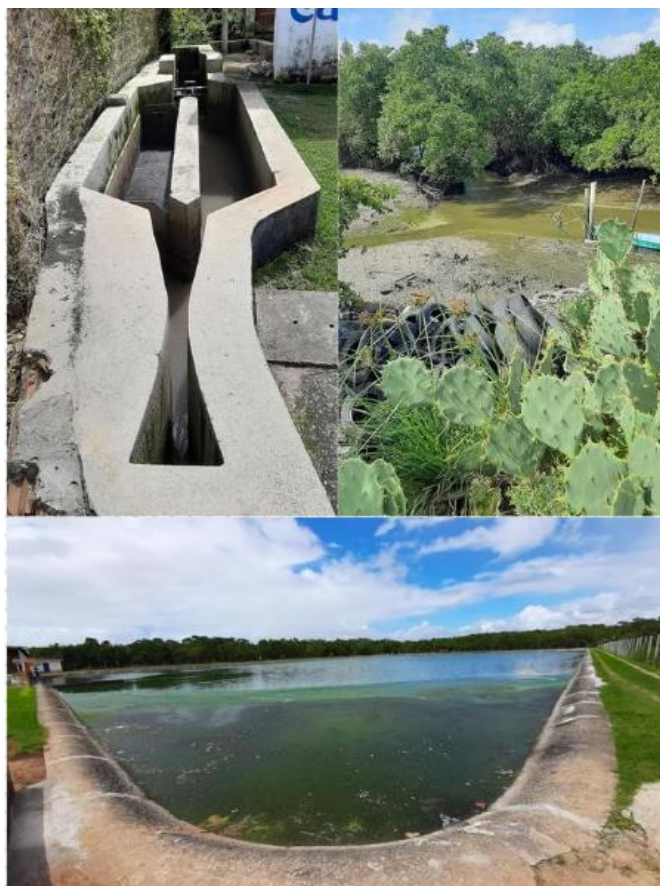
Figura 33: Estação de Tratamento de Esgoto do Jardim Lola I.
