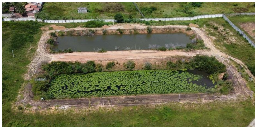
Figura 18: Lagoas de sedimentação de resíduos.
