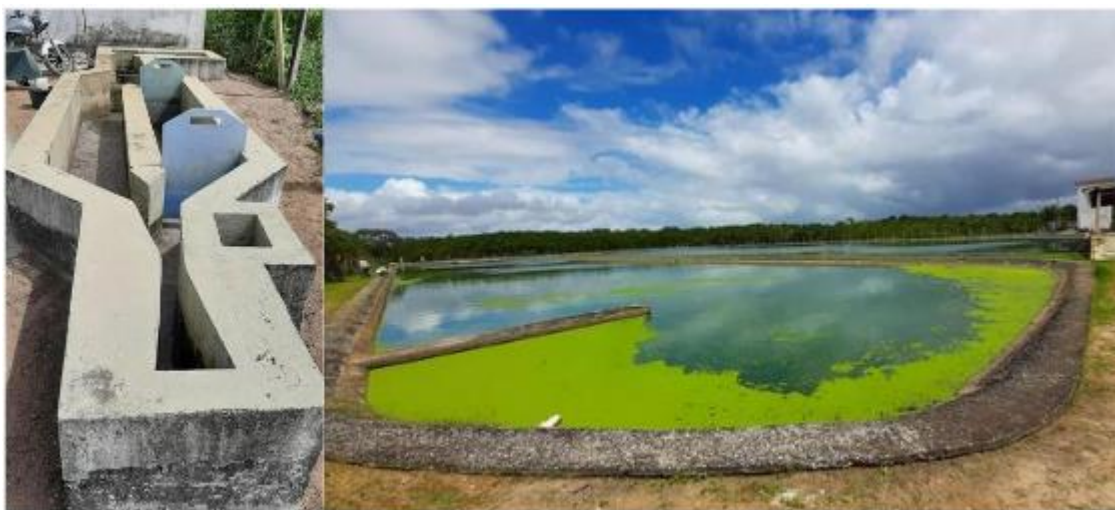
Figura 34: Estação de Tratamento de Esgoto do Jardim Lola II.
