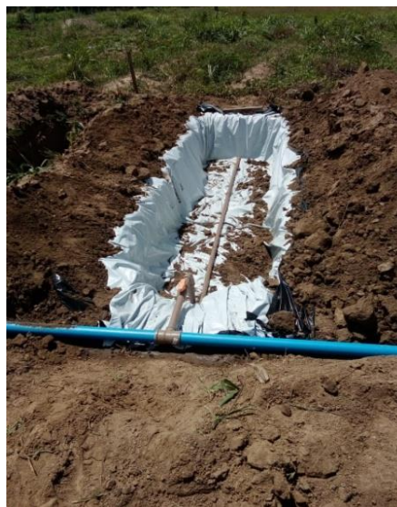
Foto 4: Detalhe da disposição da lona no canteiro montado. Fonte: Arquivo pessoal.
