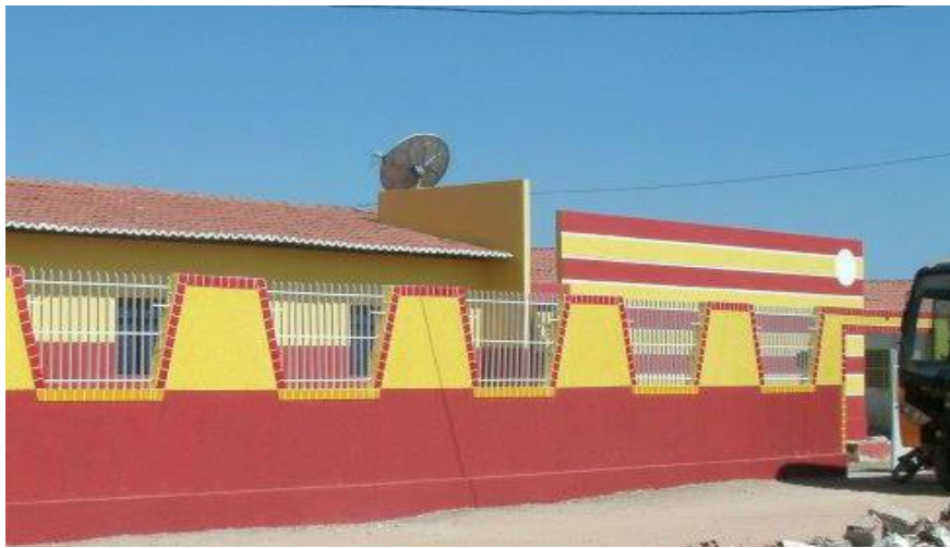
Figura 03. Escola Municipal Santa Maria – Ensino fundamental
