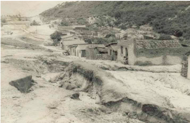
Figura 16: Rua João XXIII antes da Frente de Trabalho — anos 1960.
