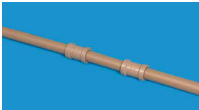
Figura 6 – Luvas de correr aplicadas nas extremidades do novo trecho.
