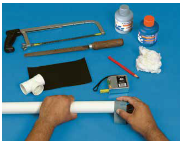
Figura 27 – Preparação para juntas soldáveis.
