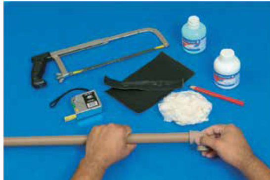
Figura 15 – Encaixe da conexão na ponta do tubo.
