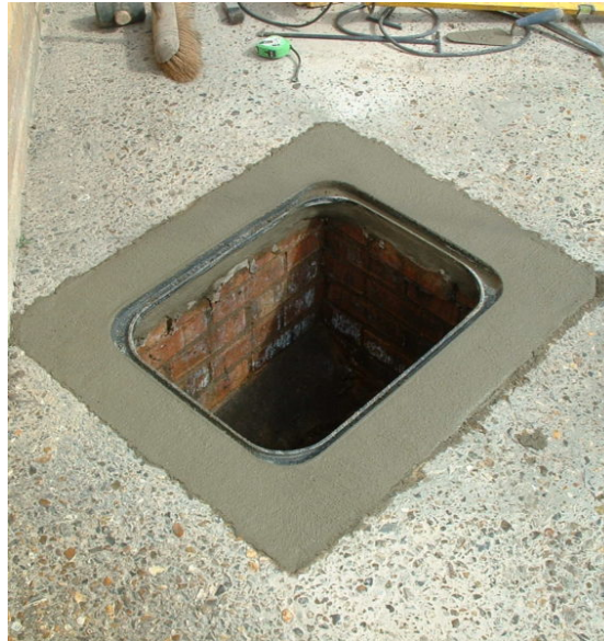
Figura 8 – Caixa de inspeção em alvenaria de tijolos.
