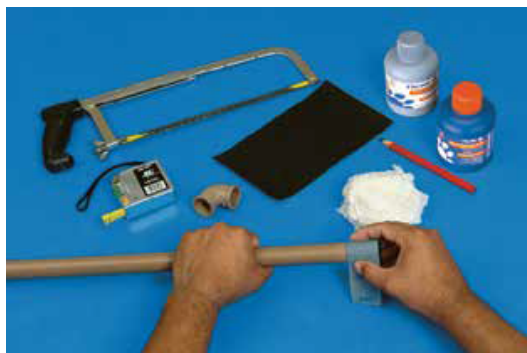
Figura 12 – Lixação de tubulação de PVC.
