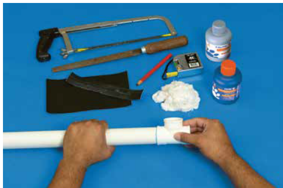
Figura 30 – Encaixe das peças.
