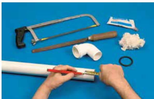
Figura 33 – Marcação da bolsa na ponta do tubo.
