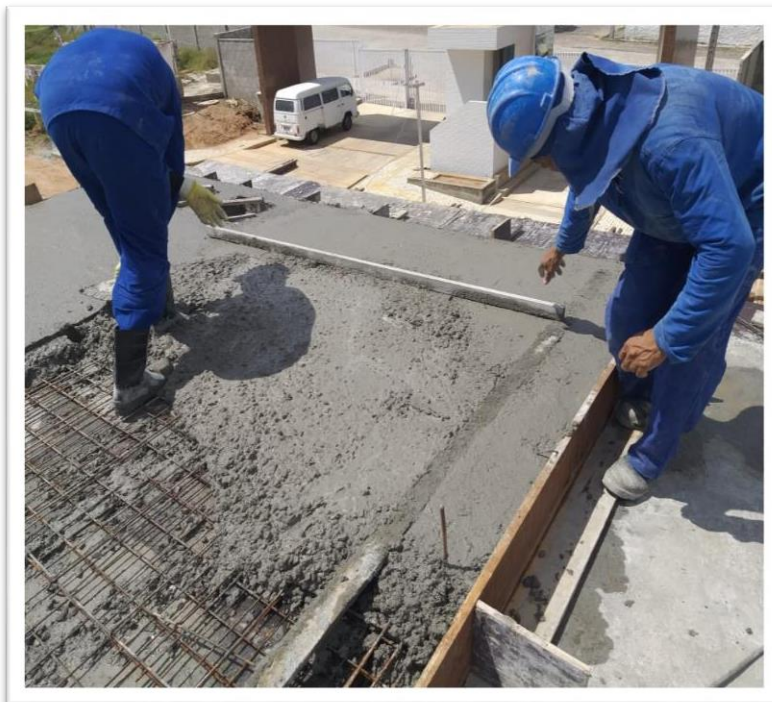
Figura 1- Concretagem em laje de cobertura
