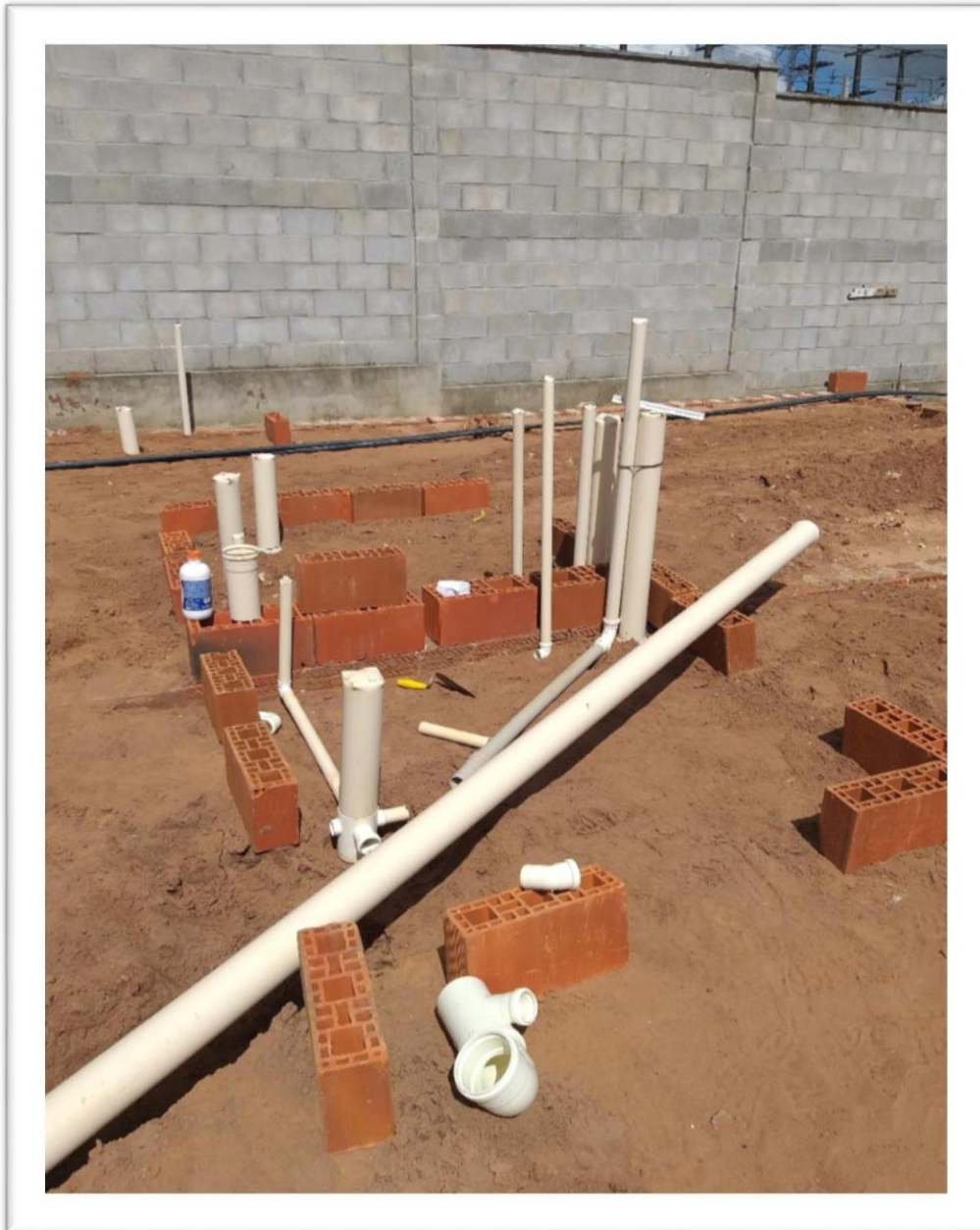
Figura 9 – Execução do esgoto
