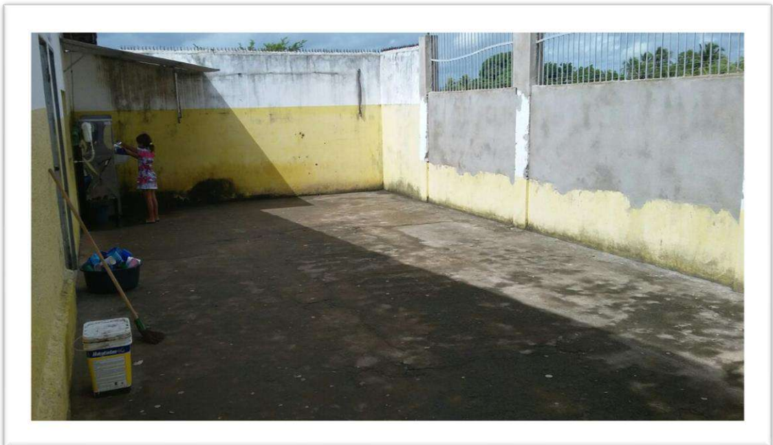
Fotografia 8: Local onde será construído refeitório.
