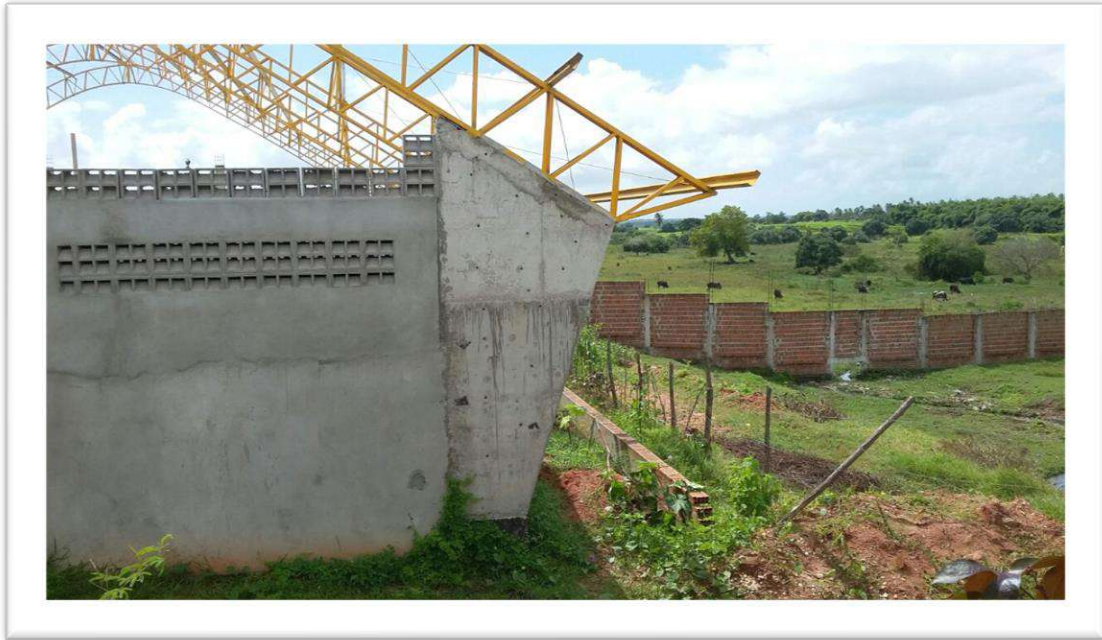
Fotografia 17: Construção da quadra Poliesportiva
