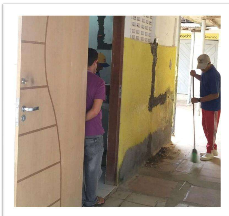
Fotografia 16: Reforma no banheiro adaptado para deficientes
