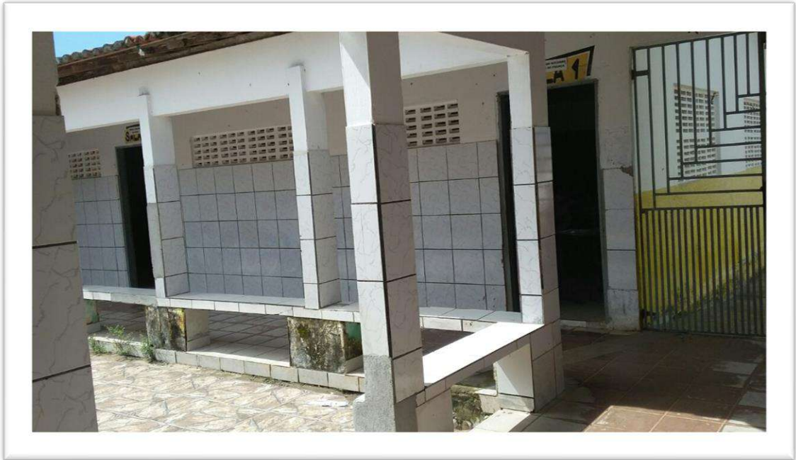
Fotografia 7: Acesso a salas e Refeitório.
